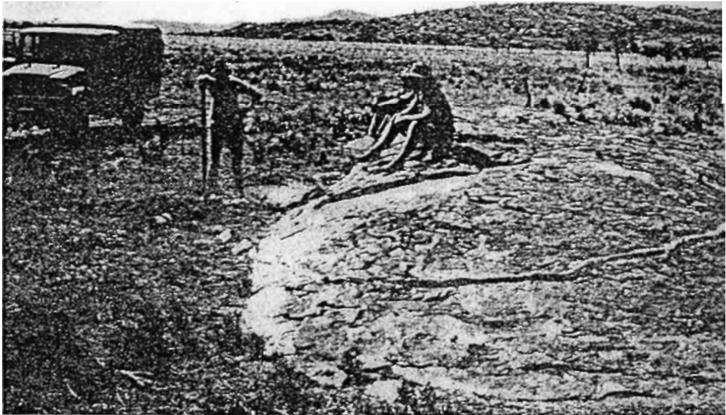
PHOTO 5.7 : WOMNIKUTTA — UN PETIT DÔME MUNI D'UNE GOUTTIÈRE EN CIMENT PAR ANDREW ET KIM MÈNE A UN ENCLOS PLANTÉ DE PISTACHIERS (VOIR FIG. 5.5). LA GOUTTIÈRE RESSEMBLE A UN SERPENT SUR LE ROCHER.
